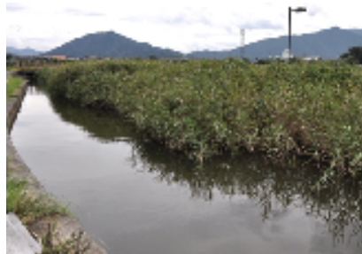
St⑤. 荒井中央幹線排水路:圃場整 備時に出来た中央承水路。幅6~8m のコンクリート護岸。河口域には泥が 堆積、上流域は砂礫土砂が堆積する。
