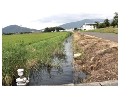
St⑦. 美浜体育館北排水路:美浜町総 合運動公園脇の水田排水路。幅2mの アーム柵護岸。底床には泥が堆積する。 増水時には流速が速い。
