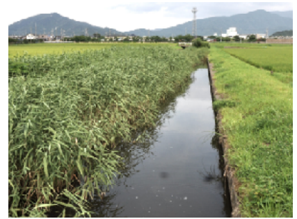
St⑧. 西部幹線排水路:美浜町水田 の西部幹線承水路。久々子漁協船置 き場に注ぐ幅8mのコンクリート護岸排 水路。底質は泥質から砂礫状。右岸 にはヨシが繁茂する。
